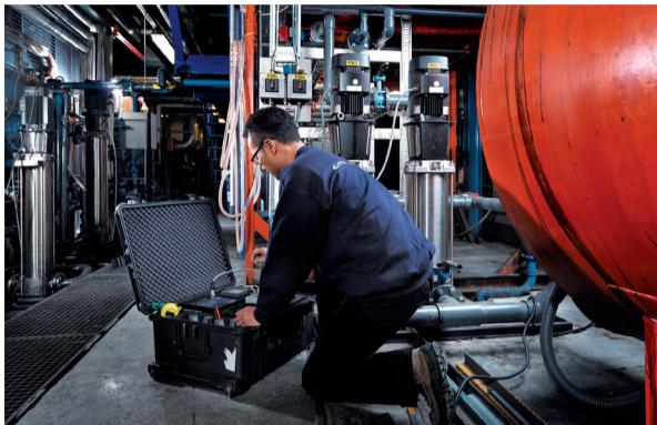
在泵系统节能效率分析评估技术的帮助下，用户可以采集泵系统安装和使用中的各项数据
